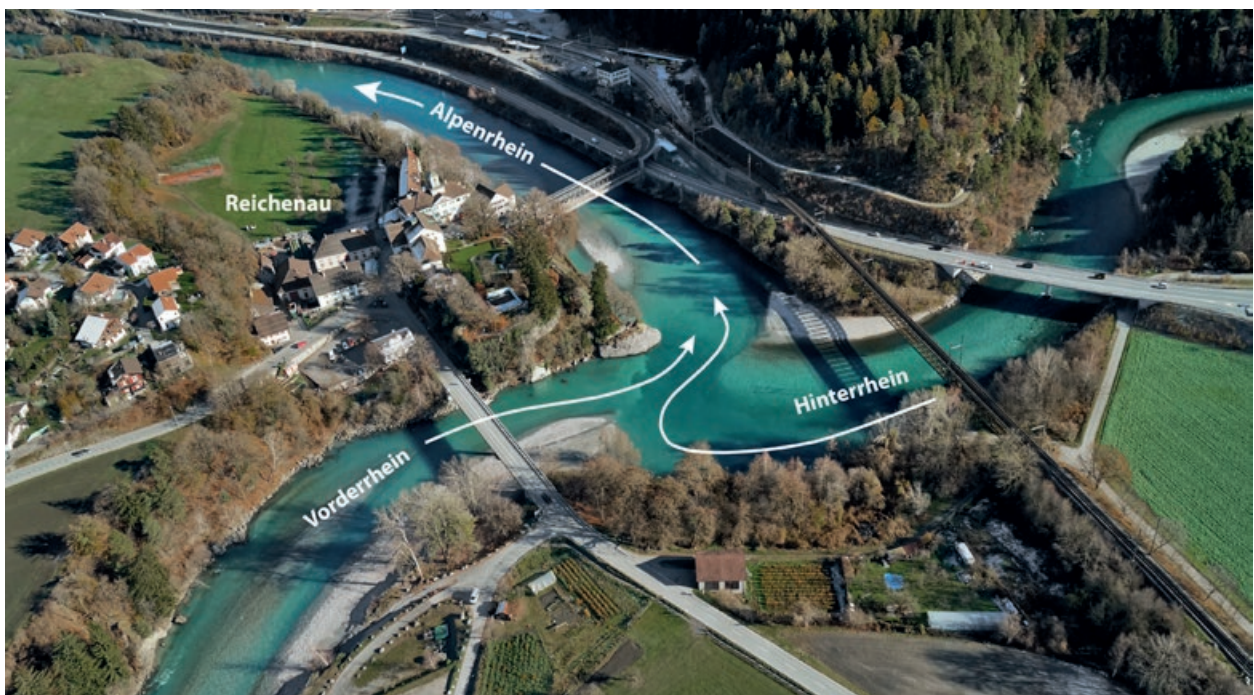
Abb. 1: Ursprung des Alpenrheins: Bei Reichenau (Graubünden) fließen Vorderrhein und Hinterrhein frontal aufeinander zu und vereinigen sich zum Alpenrhein, der von hier aus noch 90 km auf seinem Weg in den Bodensee zurücklegt und dabei mit St. Gallen einen zweiten Schweizer Kanton, des Fürstentums Liechtenstein und Vorarlberg (Österreich) streift. Foto: HYDRA 2014 ©.
